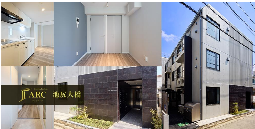
J-ARC 池尻大橋 外観および内観写真
